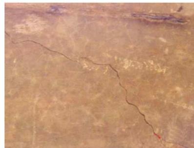
Figura 3-14. . Grieta a cortante en viga principal de concreto reforzado. Espesor de la grieta mayor a 0,6 mm. Regional Boyacá. Fuente: (Muñoz, 2011) h
