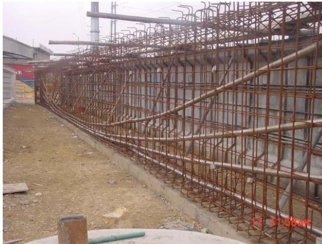
*Figura 3-19* Viga postensada de puente en construcción. Fuente: Propia.
