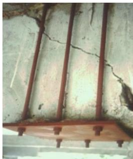
Figura 3-13 Grieta a cortante en viga principal de concreto reforzado, con un espesor mayor de 0,6 mm. Fuente: (Muñoz, 2011) h
