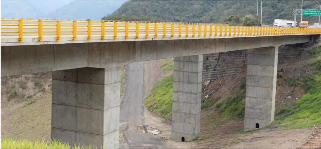
**Figura 2 - 9. Fotografía de puente K55 (Voladizos Sucesivos) - Calzada Derecha.**
