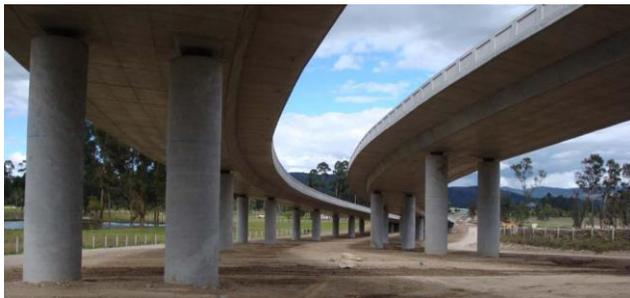
Figura 2 - 15.Ejemplo de losa aligerada apoyada sobre columnas con aisladores sísmicos. Puente Porteachuelo Fuente: Autorizado para su publicación por la referencia (Rosillo et al., 2009)
