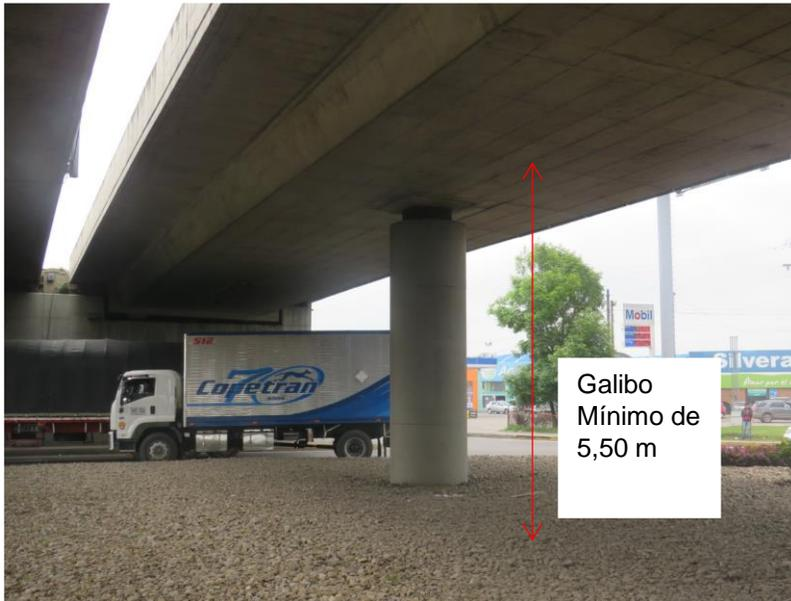
Figura 2 - 24.Ejemplo de galibo de puente - Intersección Siberia sobre carretera - Honda - Villeta. Fuente: Propia
