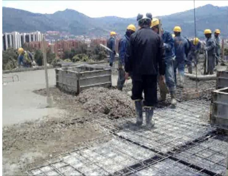
**f.Fundida del concreto del entrepiso:** En este paso se funde la losa junto con las vigas y viguetas. El concreto generalmente es llevado por medio de una bomba hasta el nivel donde se esté fundiendo el entrepiso. Se esparce el concreto mediante palas al mismo tiempo que se hace el proceso de vibrado. Después se va nivelando mediante la boquillera
