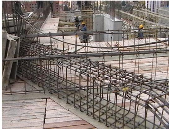
**d. Instalación del material de aligeramiento:** Una vez se tiene el armado de las vigas y viguetas, se coloca el material de aligeramiento. Este puede ser casetón de guadua o de poliestireno recubierto con polietileno
