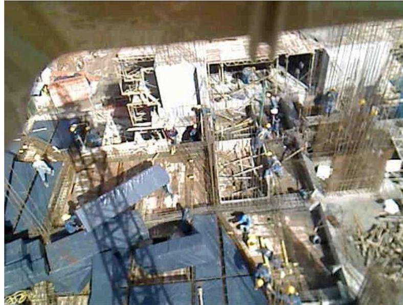
**e. Instalación de la parrilla de la losa:** En esta etapa se instala el acero correspondiente de la losa. En el caso de la losa superior de un entrepiso aligerado combinado con viguetas, se diseña su refuerzo a flexión y se verifica que el espesor de concreto asuma su resistencia a cortante. Es necesario colocar un refuerzo mínimo a este tipo de losa, de tal forma se evita la presencia de fisuras producto de retracción y fraguado del concreto.
