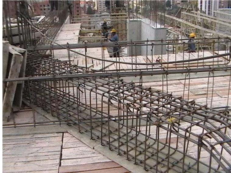
**Figura 4 - 22** Ejemplo de refuerzo de una viga principal y algunas viguetas
