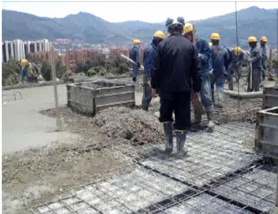
**Figura 4 - 24 Fundida del concreto del entrepiso**
