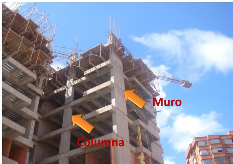
Figura 4 - 52 . Edificio de concreto en construcción. Identificación de un un muro y una columna. Fuente: Suarez - 2013 [ 1].
