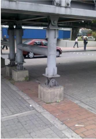
Figura 4 - 54 Ejemplo de pedestal que soporta pila de acero de puentes peatonal. Fuente: Suarez - 2013 [ 1].
