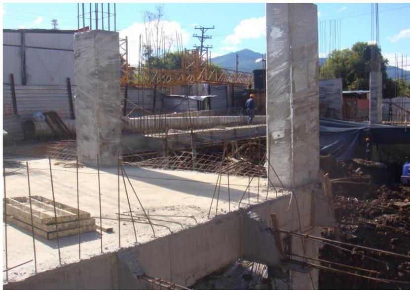
Figura 4 - 87 Curado de una columna
