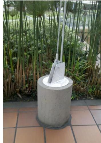
Figura 4 - 55 Ejemplo de pedestal que sirve de anclaje de cable cubierta. Fuente: Suarez - 2013 [ 1].
