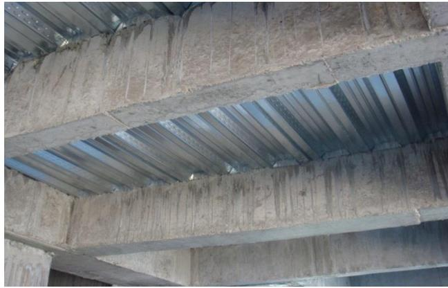
Figura 4 - 11 Ejemplo de losa más “Steel Deck” con viguetas en una dirección
