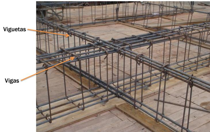
Figura 4 - 89 Ejemplo de viga principal y viguetas. Fuente: Suarez – 2013 [ 1].
