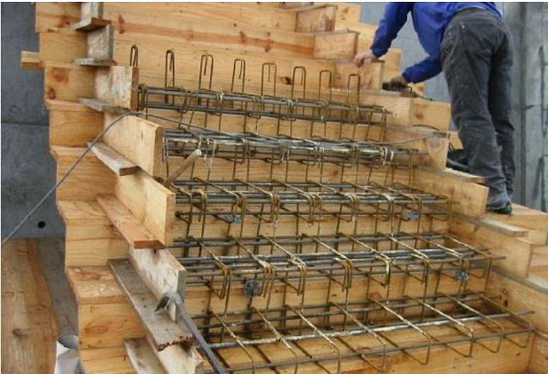
Figura 3 - 64 Escalera de una sola línea. Fuente: Tomado Diseño de escaleras de concreto.
