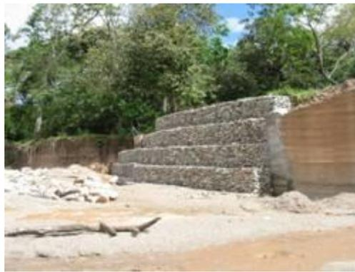
Figura 3 - 38. Gaviones para protección de aletas y estribo. Fuente:(E. Muñoz, 2011)
