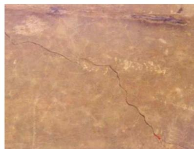
Figura 3 - 31. Grieta a cortante en viga principal de concreto reforzado, con un espesor mayor de 0,6 mm.
