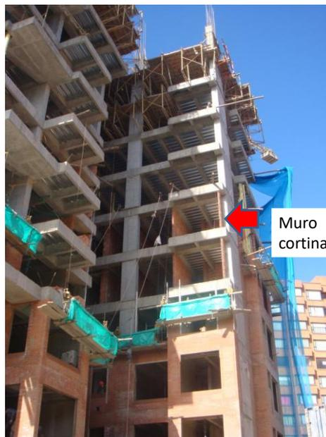
Figura 3 - 54 Muro cortina en edificio en construcción.
