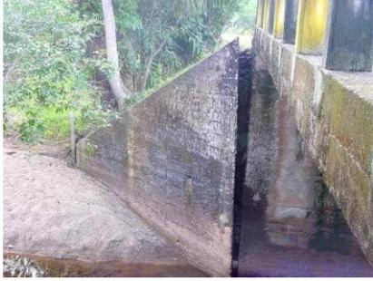
Figura 3 - 49. Ejemplo de puente con estribo con aletas independientes. Regional Caquetá
