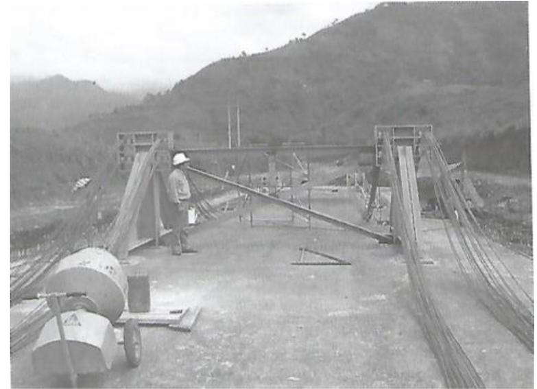
La solución consistió con un apoyo provisional y un nuevo sistema de cables para la unión entre la nariz de lanzamiento y la viga de concreto postensado tipo cajón de 65 metros de luz. Fuente: Asocreto(2010)
