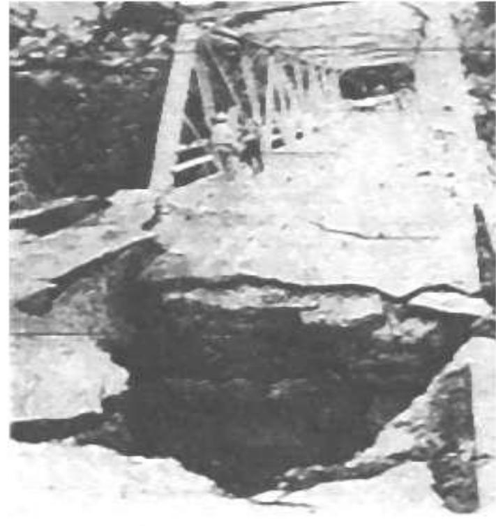
Sabandija(Tolima). falló por socavación producto de una creciente de una quebrada afluente al río Fuente: Muñoz E.E (2012)
