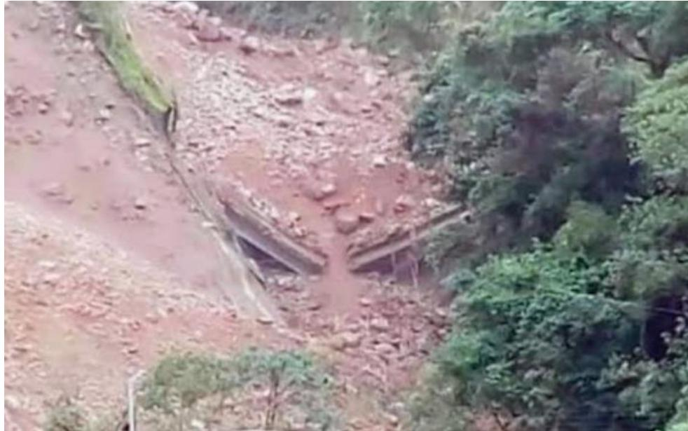
Puente entre los túneles 13 y 14 de la carretera Bogotá Villavicencio. Falla por carga producida por deslizamiento de la montaña K58 Fuente: <http://www.portafolio.co>
