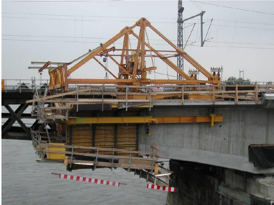
Figura 10-12 Ejemplo de carro de avance. Fuente. Notas de clase de ingeniero Oscar Patiño
